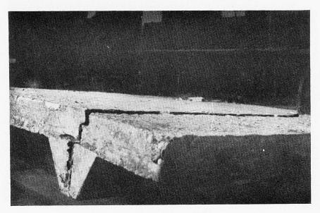
Fig. 8. — Fissure longitudinale avec déplacement de la poutre.
