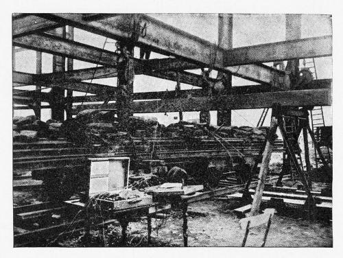
Fig. 5. Disposition du chantier d'essai de la ferme A 16. Anordnung des Bauplatzes während der Versuche am Binder A 16. Arrangement of builders' yard for testing the principal truss A 16.
