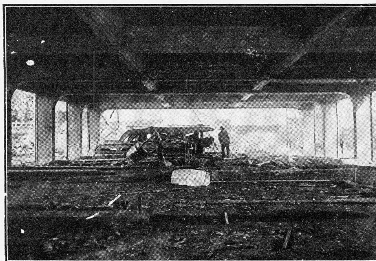
Fig. 2. Vue de l'étage inférieur de la charpente après enrobage. Ansicht des unteren Stockwerkes des Ständerbaues nach der Einbetonierung. View of the lower floor of the steel-construction after pouring the concrete.
