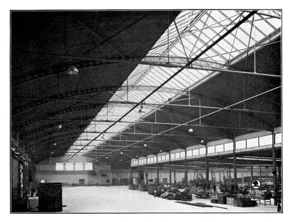
Fig. 1. — Hall de montage pour avions, Parague. Portée des arcs 24 m. Construction entièrement soudée aux ateliers et vissée sur place.
