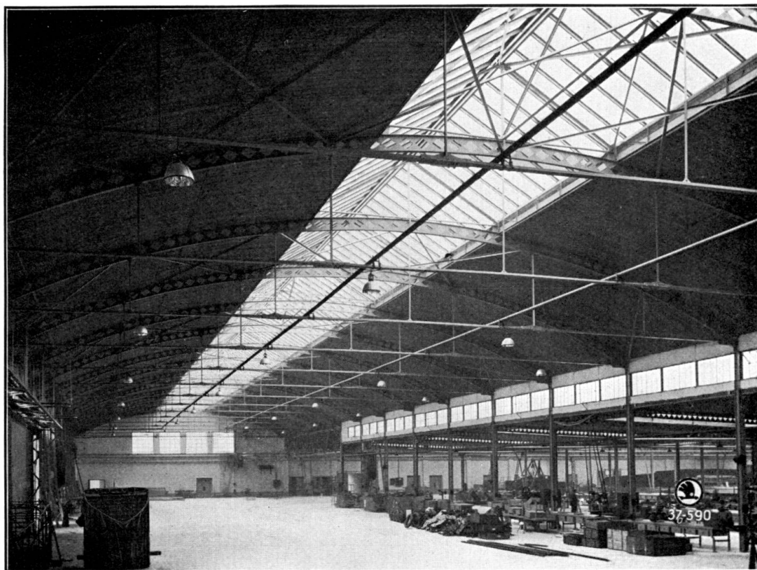
Fig. 1. — Hall de montage pour avions, Prague. Portée des arcs 24 m. Construction entièrement soudée aux ateliers et vissée sur place.
