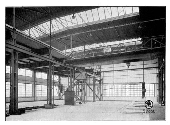
Fig. 3. — Ateliers de pressage des tôles et pont électrique à Plzeň.
