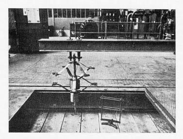
Fig. 1. — L'appareil Le Rolland en essai sur la poutre vibrante de l'Office des Inventions.
