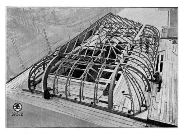
Fig. 2. — Charpente de toiture entièrement soudée, au-dessus de la salle de l'Hôtel à Plzeň.
