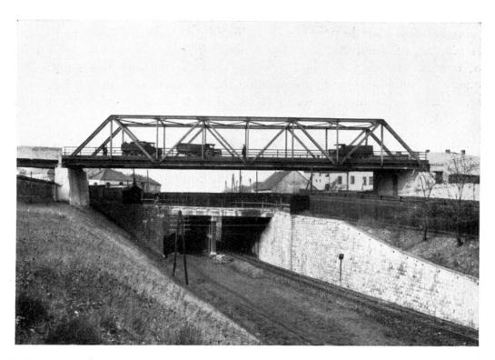
Fig. 5. — Le plus grand des ponts entièrement soudés : Pont-route à Plzeň. Portée 49,2 m. Die grösste vollkommen geschweisste Brücke : Strassenbrücke in Pilsen. Spannweite 49,2 m. The largest completely Welded Bridge : Road Bridge in Plzeň, Span 161 ft. 5 in.
