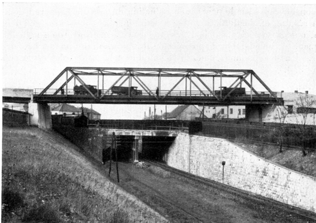
Fig. 5. — Le plus grand des ponts entièrement soudés : Pont-route à Plzeň. Portée 49,2 m. Die grösste vollkommen geschweisste Brücke : Strassenbrücke in Pilsen, Spannweite 49,2 m. The largest completely Welded Bridge : Road Bridge in Plzeň, Span 161 ft. 5 in.
