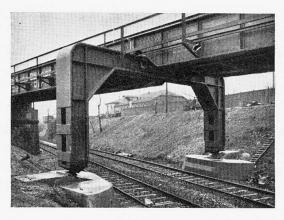
Fig. 1. — Cadres soudés pour un ouvrage de croisement à Vohwinkel, portée 10 mètres. Geschweisster Rahmen für ein Kreuzungsbauwerk bei Vohwinkel, Stützweite 10 m. Welded frames for an overhead crossing at Vohwinkel; span 10 metres.
