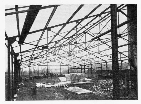
Fig. 7. — Bâtiment soudé par Points — Punktgeschweisste Halle — Building constructed by spot welding.
