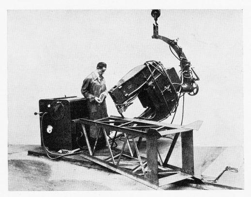
Fig. 5. — Machine inclinée soudant un pylône — Geneigte Maschine beim Schweissen eines Mastes — Machine inclined, welding a pylon.
