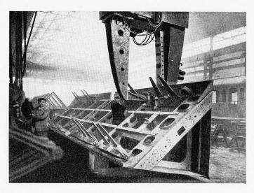
Fig. 9. — Fond de wagon en cours de soudure = Schweissung eines Wagenrahmens = Welding a wagon frame.
