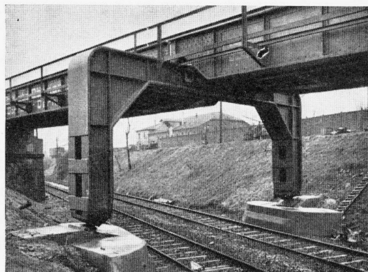
Fig. 1. — Cadres soudés pour un ouvrage de croisement à Vohwinkel, portée 10 mètres. Geschweisster Rahmen für ein Kreuzungsbauwerk bei Vohwinkel, Stützweite 10 m. Welded frames for an overhead crossing at Vohwinkel; span 10 metres.
