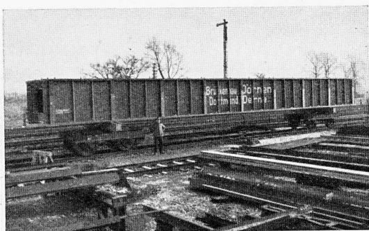
Fig. 5 et 6. — Superstructure pour la gare de Barmbeck, portée environ 22 mètres. Ueberbau beim Bahnhof Barmbeck, Stützweite rd. 22 m. Box girder at Barmbeck railway station; span about 22 meters.
