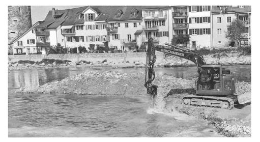
Beim Hochwasserim Sommer hat sich unterhalb des Kleinkraftwerks Bruggmühle eine grosse Kiesansammlung gebildet. Die Stauung gefährdet den störungsfreien Durchfluss. In rund zwei Wochen transportiert ein Baggerführer dieses Kies in die Flussmitte. Dort soll es von der natürlichen Wasserströmung abgetragen werden. Foto: BBA.
