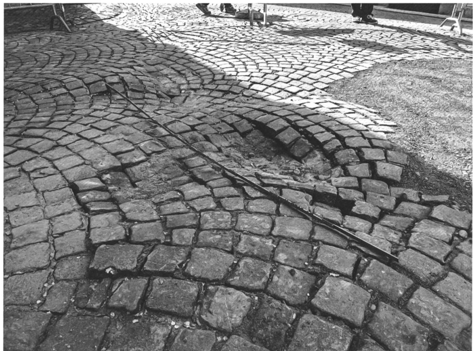
Rohrbruch am Kreuzplatz: Zerstörte Pflasterung infolge geborstener Wasserleitung. Foto: Stefano Righetti.
