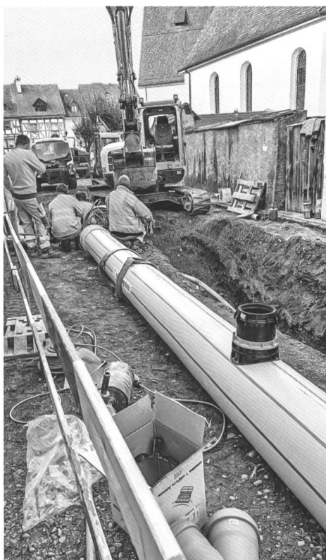
Die dicken Kunststoff- röhren des Wärme- verbundes werden in der Bremgarter Kirchgasse versenkt. Rechts im Bild St. Annakapelle und Stadtkirche. Foto: Astrid Linder.
