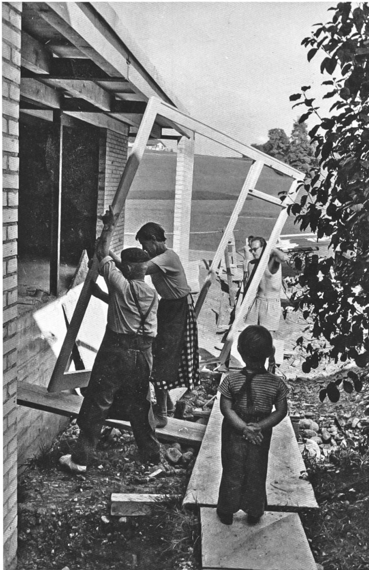
1952 baute das Ehepaar Schwarz ein Einfamilienhaus mit Flachdach am Dorfrand von Brüttisellen. Lotte Schwarz-Bennet (zweite von links) legte bei Bau selber kräftig Hand an. Foto: Ernst Scheidegger, Zürich.
