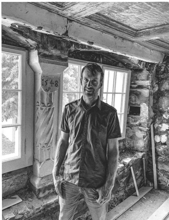
Alex Hürlimann steht neben der Säule mit der Inschrift, welche auf den Erweiterungsbau, nicht auf die Entstehung des Gebäudes hinweist. Unter anderem lässt auch das Kassetentäfer annehmen, dass diese Bürgerstube für repräsentative Zwecke genutzt wurde.
