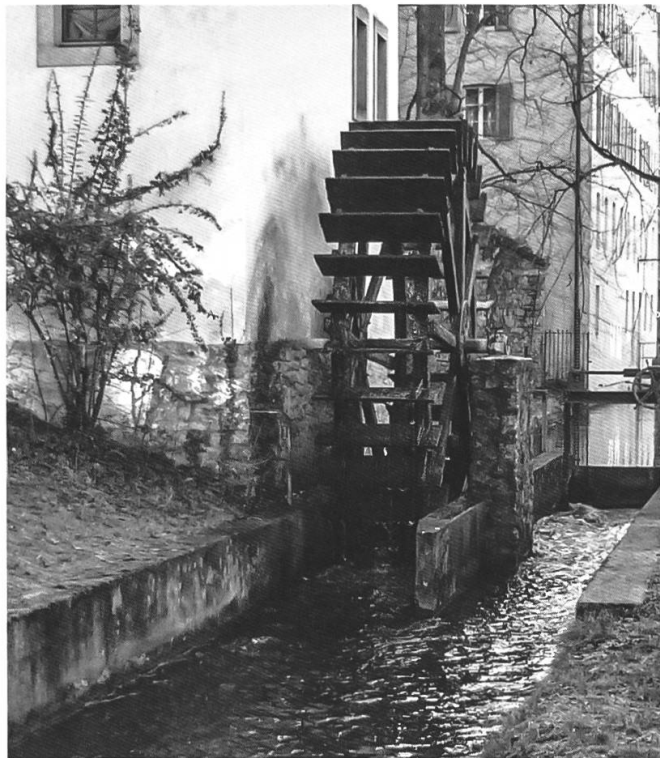
Schaufelrad bei der Aarauer Schösslimühle. Auch die Hermetschwiler Klostermühle wurde von einem stehenden Schaufelrad angetrieben. Der Wirkungsgrad eines solchen Rades war wesentlich höher als bei Stockmühlen mit liegendem Rad.
