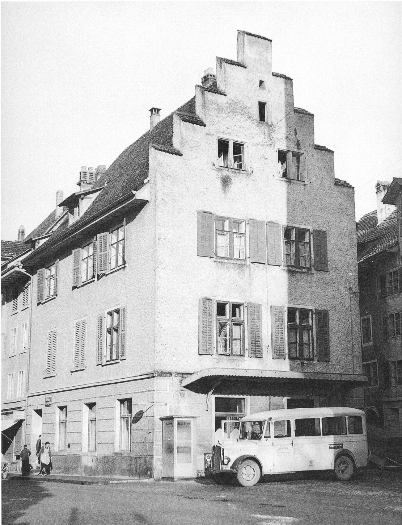
Die alte Post an der Marktasse 33 (heute Metzgerei Stierli) um 1938. Noch sind die Arkaden nicht freigelegt.
