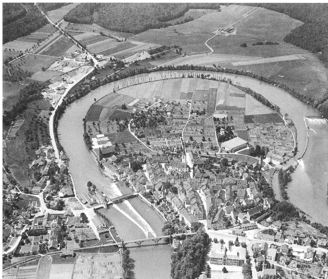
Flugaufnahme von Bremgarten des Luftfahrtpioniers Walter Mittelholzer aus dem Jahre 1929. Das Siedlungsbild dürfte sich seit 1913 kaum verändert haben. Archiv Alois Stutz, Bremgarten.
