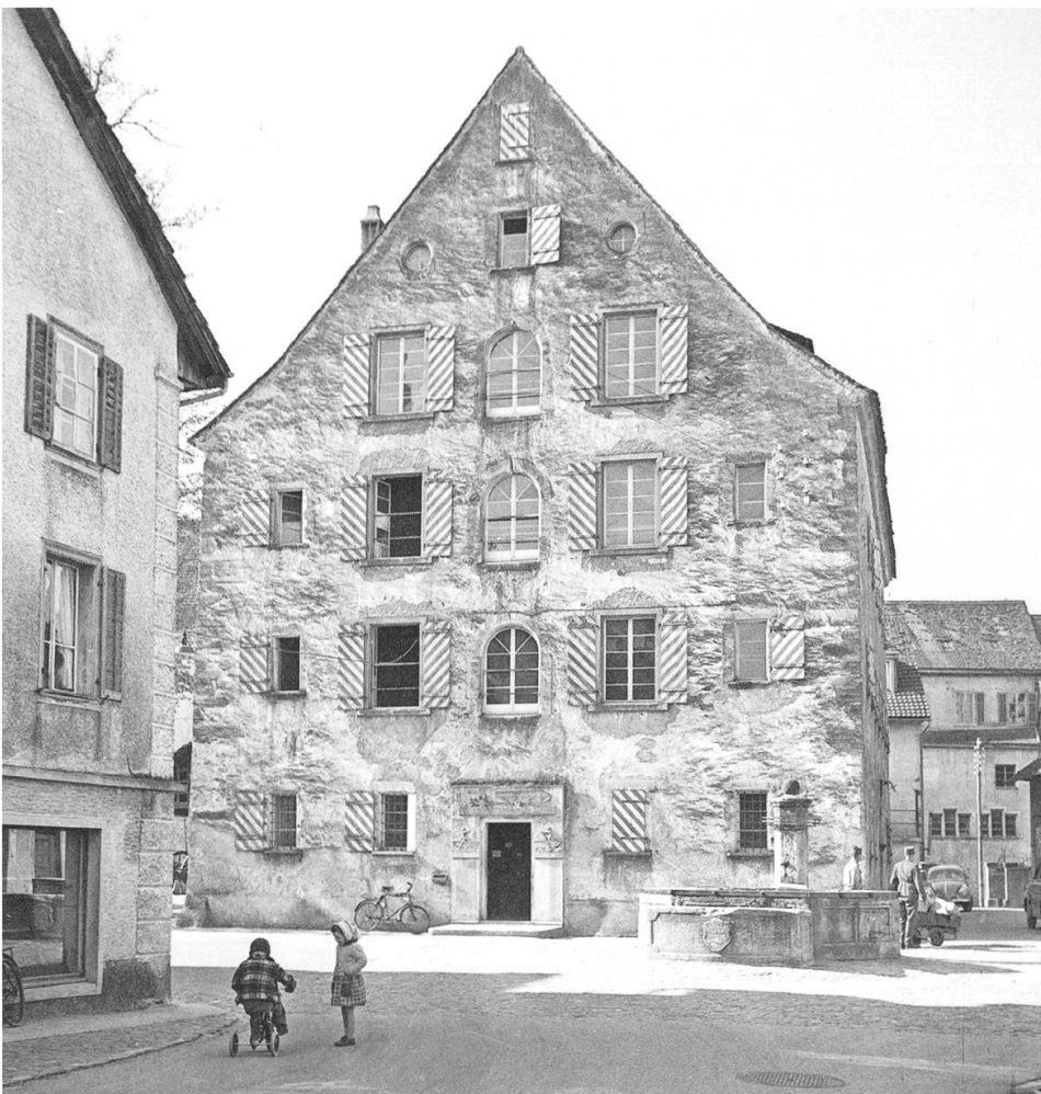
Diese Aufnahme vom Anfang der 1940er-Jahre zeigt das Kornhaus mit seiner heruntergekommenen Fassade, die auf ein renovierungsbedürftiges Inneres verweist. Einzig die Eingangstüre des wichtigen Gebäudes von 1687 wurde schon 1939 von Werner Romang ausgeschmückt mit Reliefs zur Tätigkeit der Pontoniere. Foto: Willi Wettstein, nach 1940.
