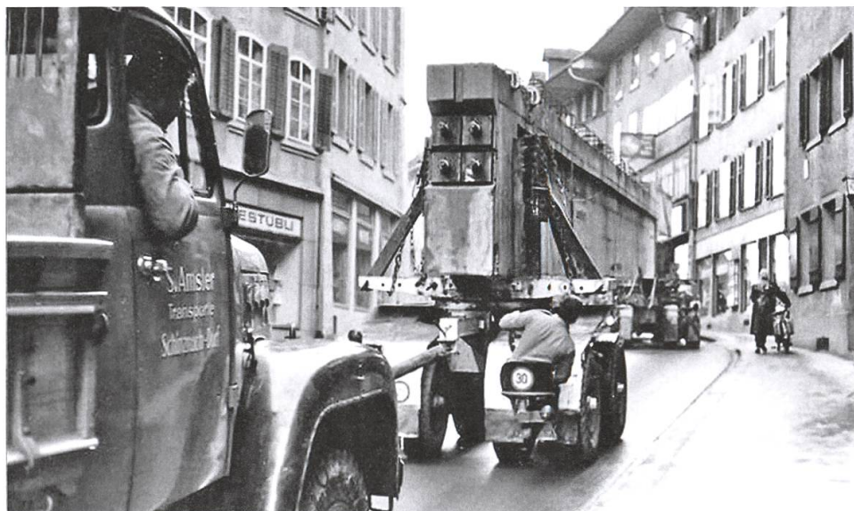
Vorne wird gezogen, hinten wird mit der Stange geschoben: Heikler Transport der vorfabrizierten Hohlkörper-Betonelemente, hier durch die enge Altstadt von Brugg, aufwärts. Foto: zvg.
