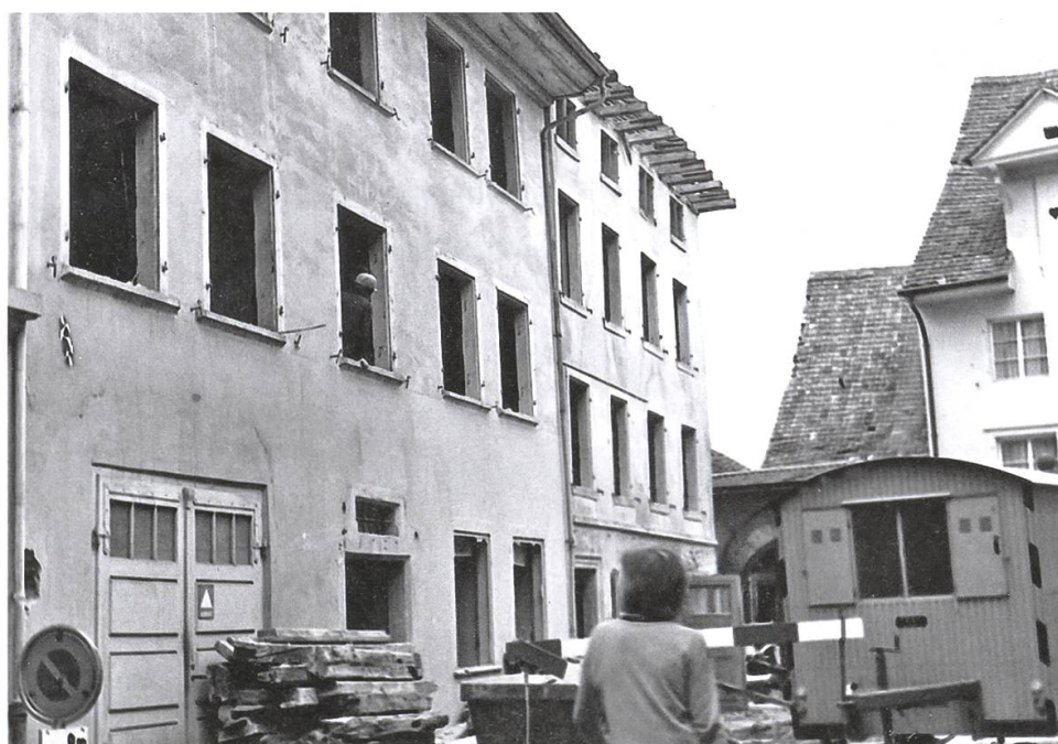
Abbruch des Weberhauses (links) und des Braunschweighauses (rechts) 1972. Foto: Archiv Beat Zeier.
