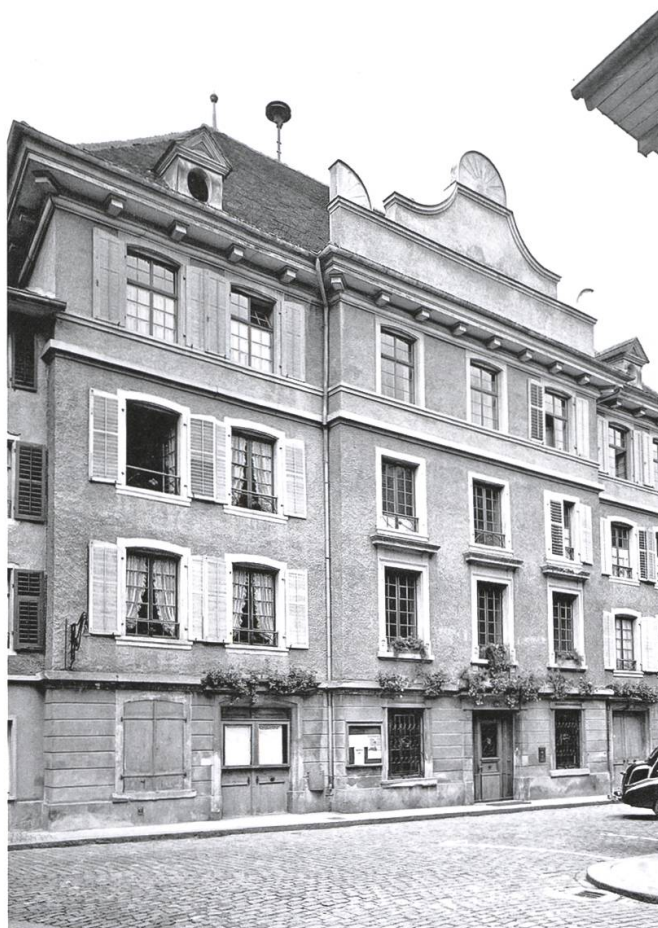
Das 1912 aufgestockte Rathaus in einer Aufnahme von 1953. Foto: Kantonale Denkmalpflege Aargau.
