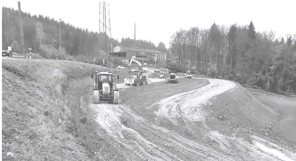
Damm-Aufschüttung. Bild: BVU/ATB.
