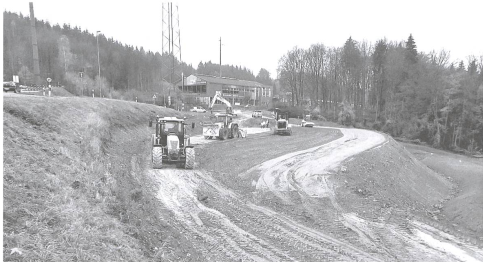
Damm-Aufschüttung. Bild: BVU/ATB.
