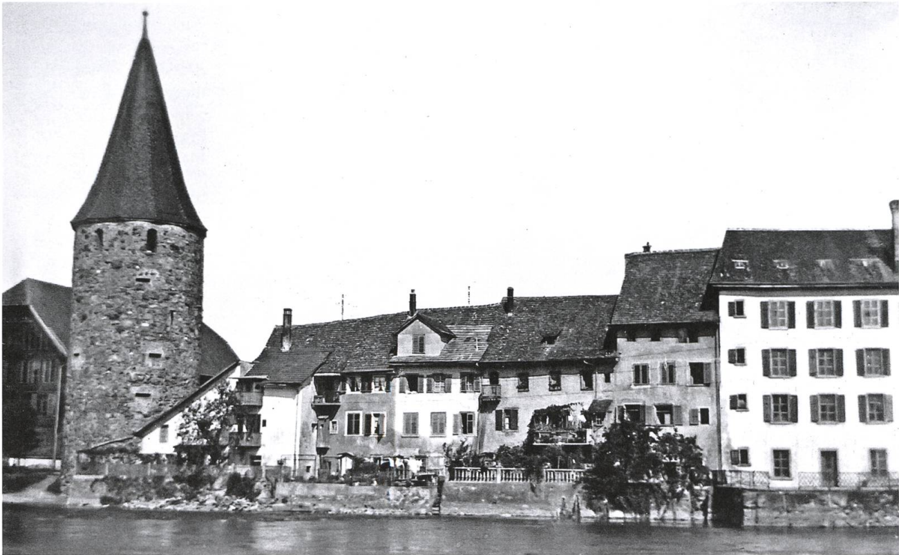
Die Westseite der Unterstadt damals mit dem Hexenturm.
