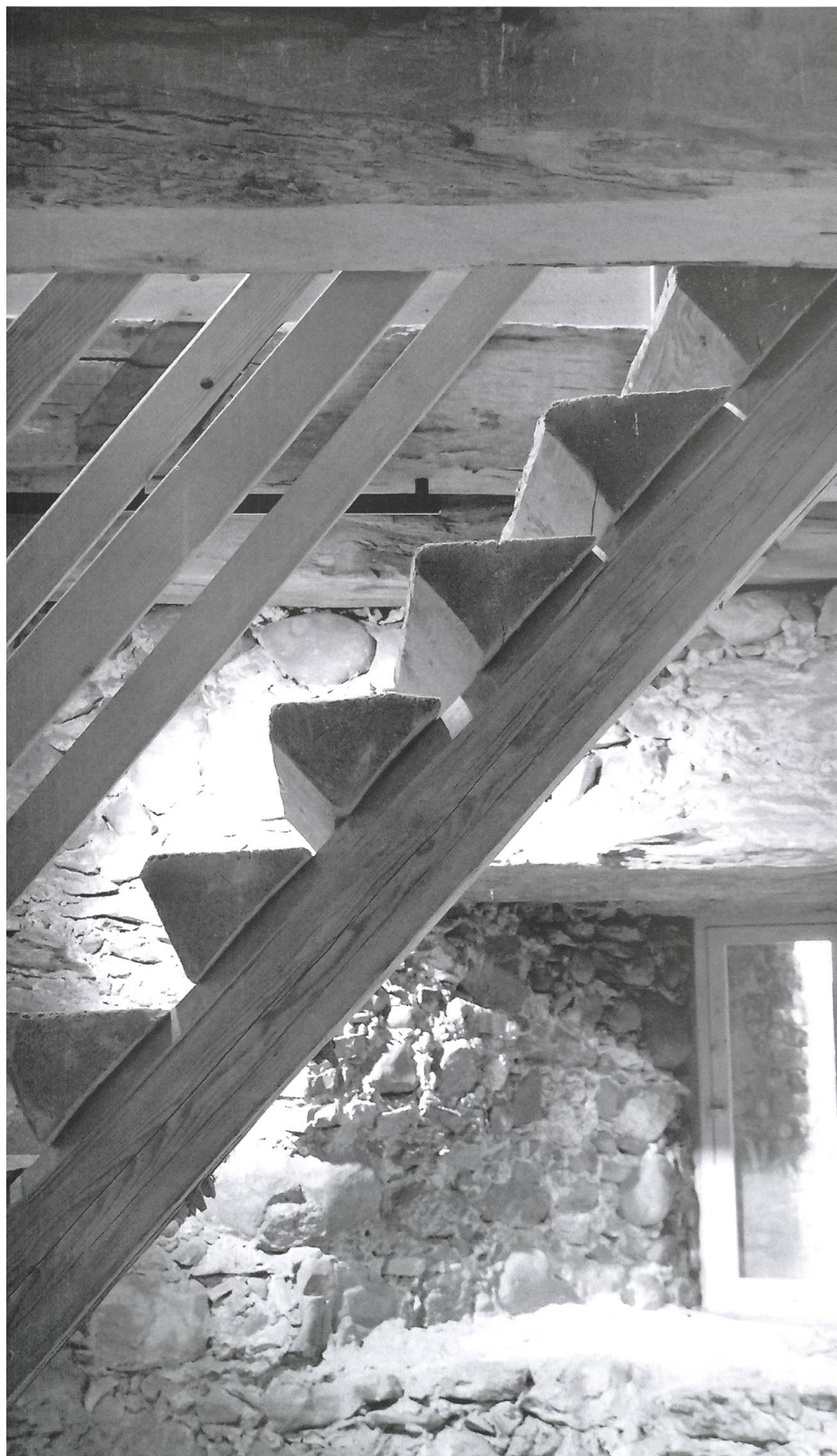
Die massiv dreieckförmigen Treppenstufen sind mit Eichennägeln auf Längsbalken aufgezogen. Die Konstruktion hat Jahrhunderte überdauert und musste nur gereinigt werden.
