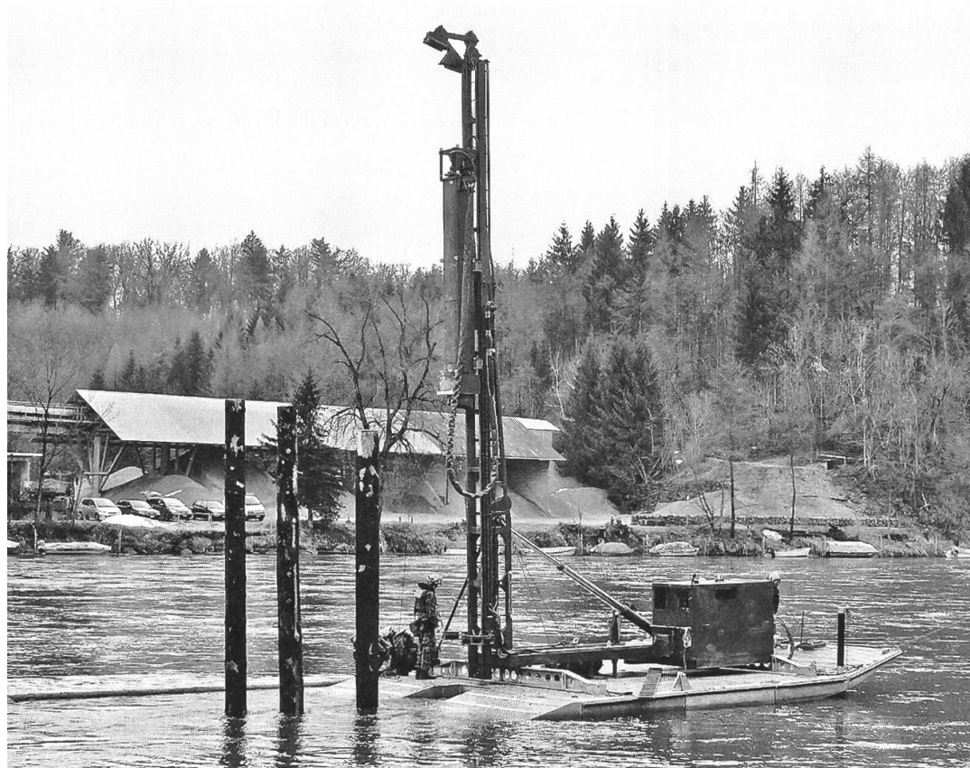
Einsatz Pfahlrammgerät.
