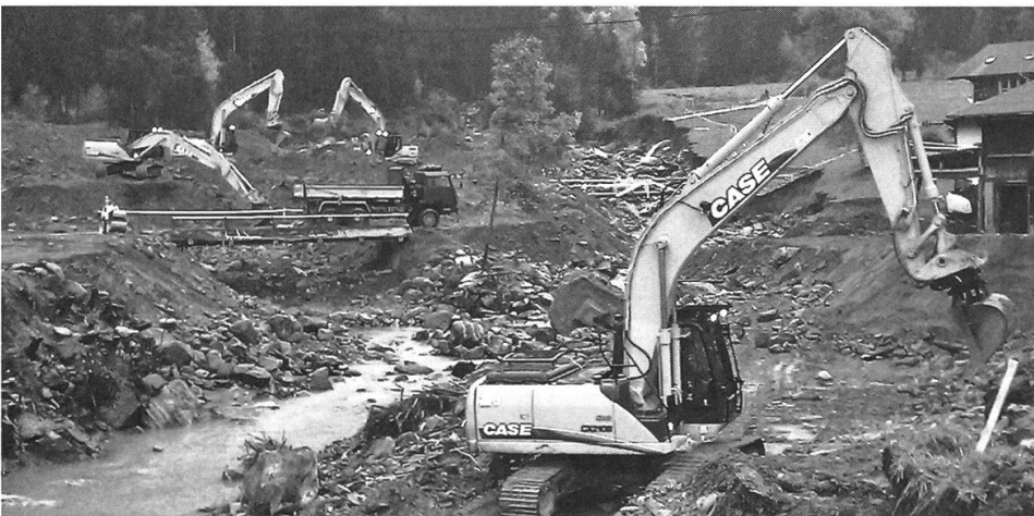
Baumaschineneinsatz im Kandertal 2011.
