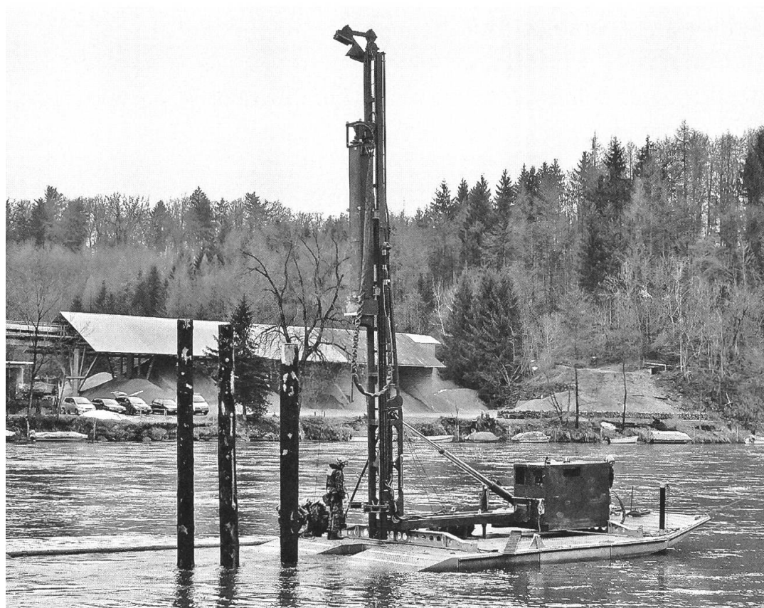
Einsatz Pfahlrammgerät.
