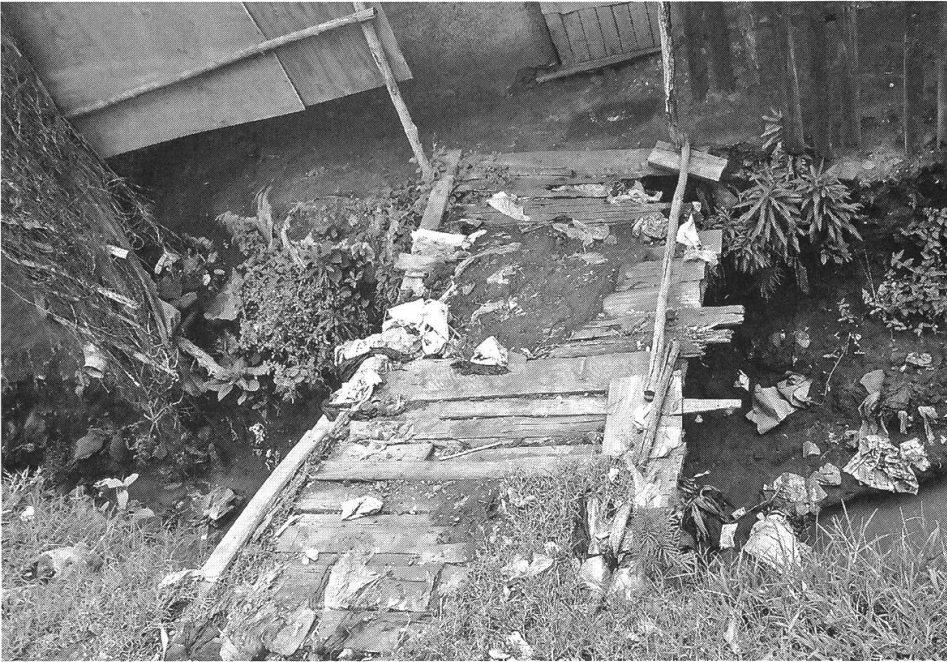
Brücke in einem Slum.
