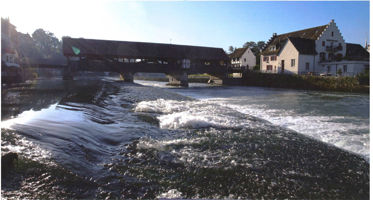
Die gedeckte Holzbrücke.
