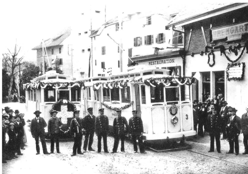
Die Station Bremgarten Obertor bei der Eröffnung am 1. Mai 1902. Foto Wikipedia
