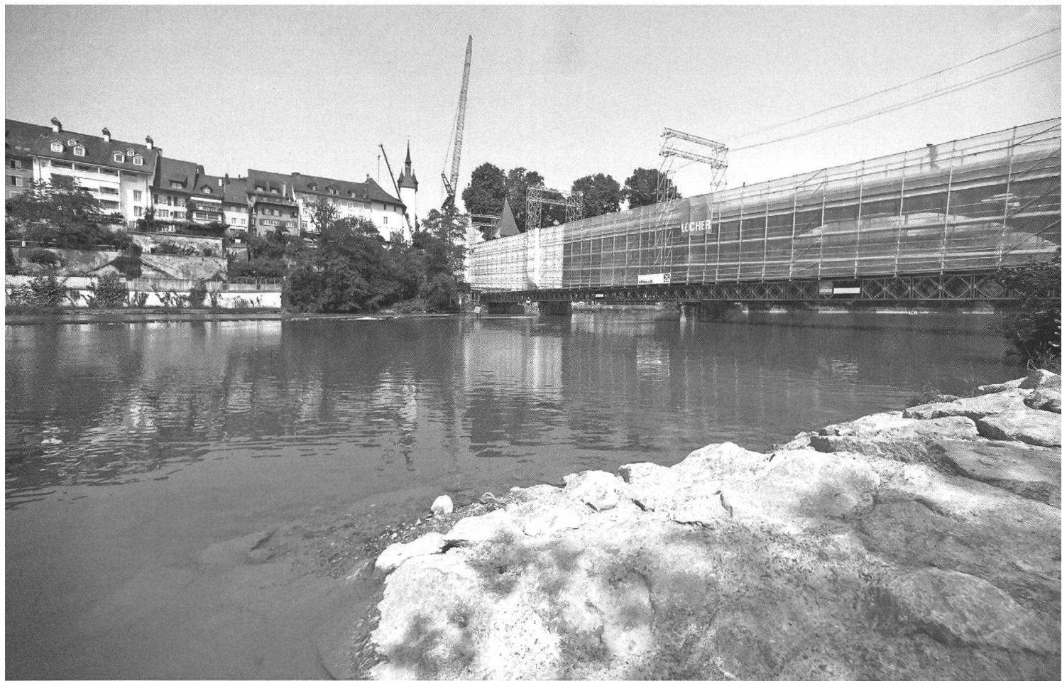
samkeit gewidmet werden, war doch der Einbau der grossen Träger von vielen Faktoren abhängig. Von der Badstrasse her konnte mit einem 220-Tonnen-Autokran der Träger für den Gerüstboden im ersten Brückenbogen auf der Unterwasserseite am Tag versetzt werden. Auf der Oberwasserseite mussten diese Versetzarbeiten wegen der Starkstromleitung an den Fahrleitungsmasten während der Zugspause in der Nacht ausgeführt werden.
