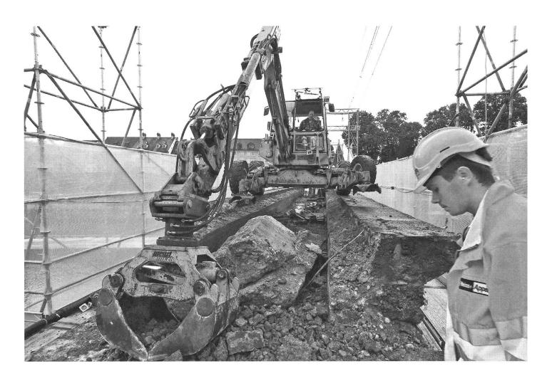
Die Zustandsaufnahmen zeigten, dass die Stampfbetonbauteile sehr heterogene Materialeigenschaften aufwiesen, d.h. Festigkeitswerte, Porosität und Saugfähigkeit variierten stark. Lokal wurden Kiesnester und Schadstellen mit zerrütteten und gelockerten Betonstrukturen festgestellt.
