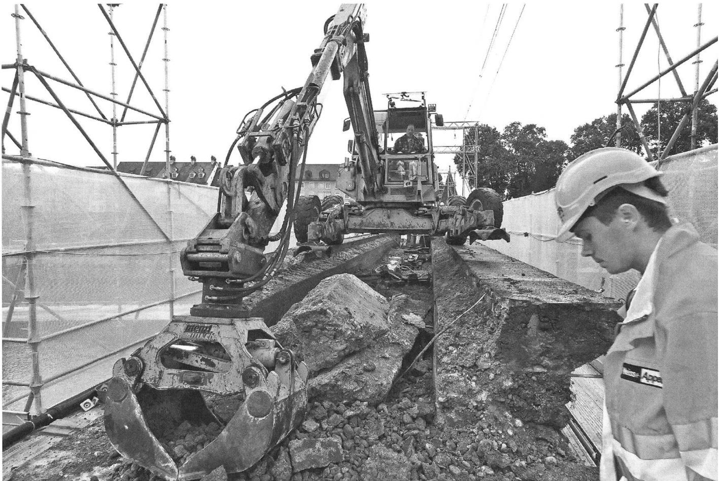
Die Zustandsaufnahmen zeigten, dass die Stampfbetonbauteile sehr heterogene Materialeigenschaften aufwiesen, d.h. Festigkeitswerte, Porosität und Saugfähigkeit variierten stark. Lokal wurden Kiesnester und Schadstellen mit zerrütteten und gelockerten Betonstrukturen festgestellt.
