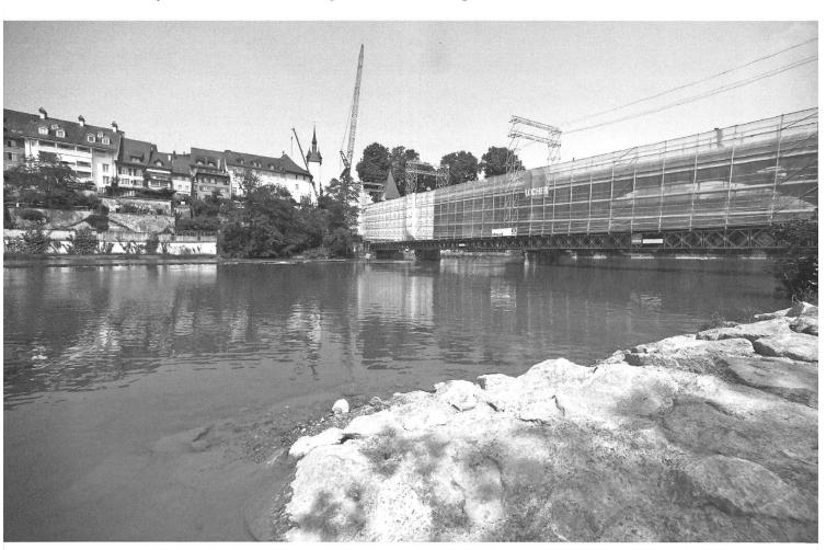
samkeit gewidmet werden, war doch der Einbau der grossen Träger von vielen Faktoren abhängig. Von der Badstrasse her konnte mit einem 220-Tonnen-Autokran der Träger für den Gerüstboden im ersten Brückenbogen auf der Unterwasserseite am Tag versetzt werden. Auf der Oberwasserseite mussten diese Versetzarbeiten wegen der Starkstromleitung an den Fahrleitungsmasten während der Zugspause in der Nacht ausgeführt werden.
