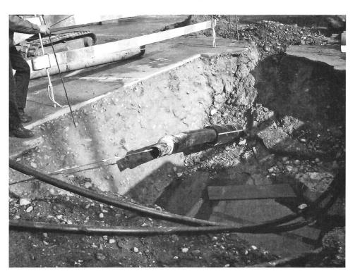
Wärmeverbund dar. Mit dieser Verbindung, welche die Reuss bis zu 19 Meter tief unterquert, werden der Ostteil der Stadt und ein Teil der Altstadt versorgt. Die hier angewendete Technik, das Spülbohren, gestattet Bohrungen über weite Distanzen. Gebohrt werden kann geradeaus oder, wie im Fall der Reussunterstossung, auch im Bogenverfahren.
