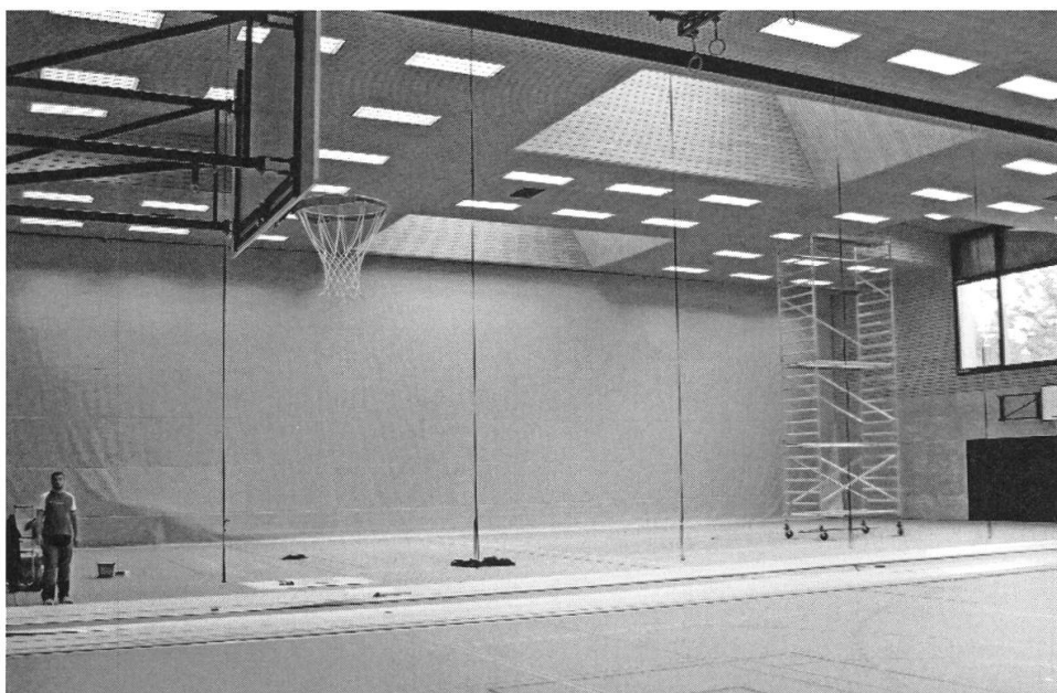
Die Montage des Trennvorhanges (Foto Pietro Mätzler)
