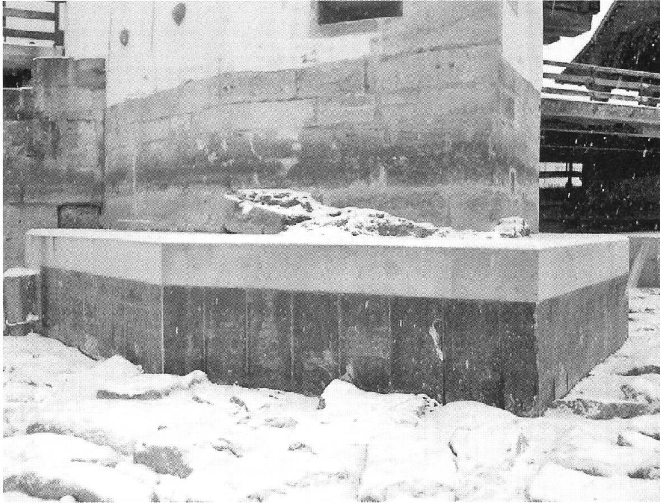
Das sanierte Fundament des Bollhauses
