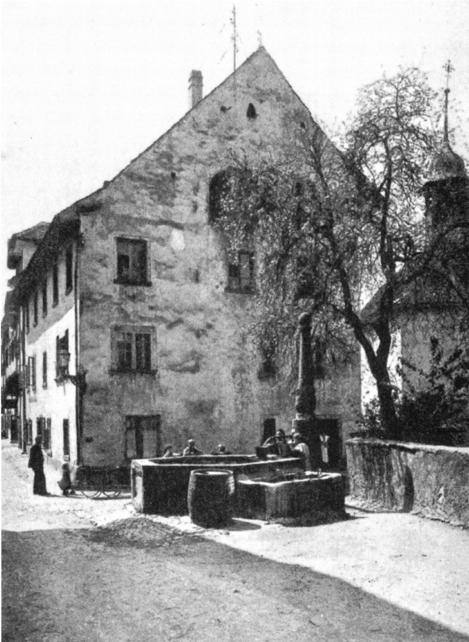
Blick von der Schulgasse in Richtung Schenkergasse mit dem Schwarzs Schlossbrunnen samt Vorbrunnen
