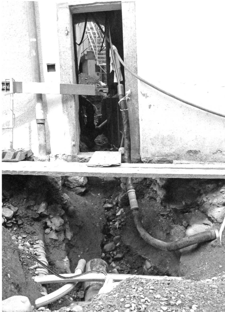
Die Befürchtungen werden bestätigt. Die Abwasser- leitungen aus dem Ehgräben lecken.
