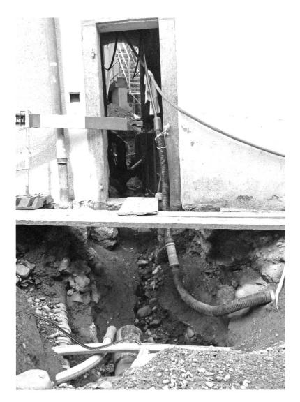
Die Befürchtungen werden bestätigt. Die Abwasserleitungen aus dem Ehgräben lecken.
