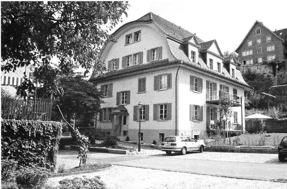
Das Haus an der Reuss nach der Renovation 2009.
