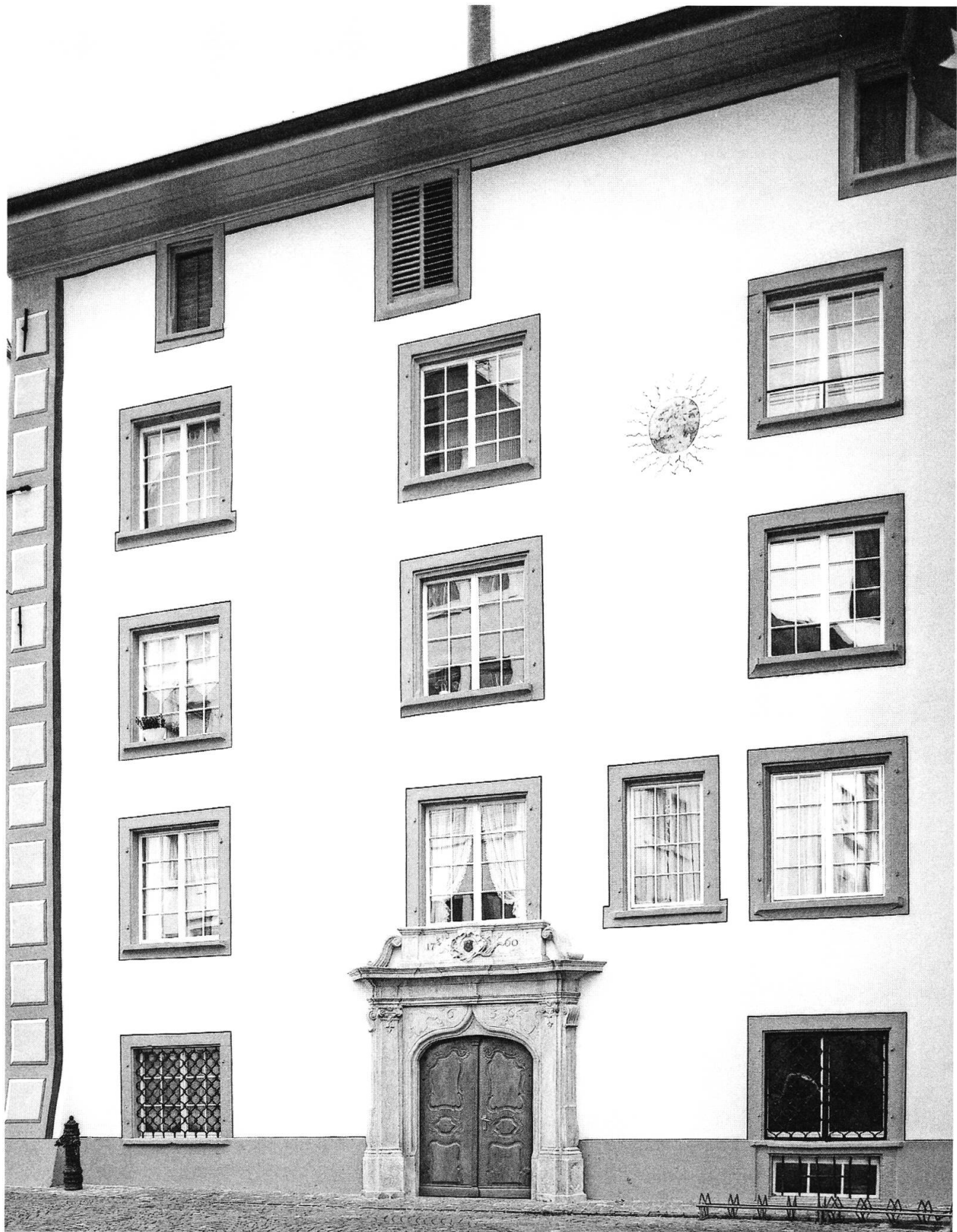
Westfassade Zustand 2008. (Bildarchiv Kantonale Denkmalpflege Aargau)
