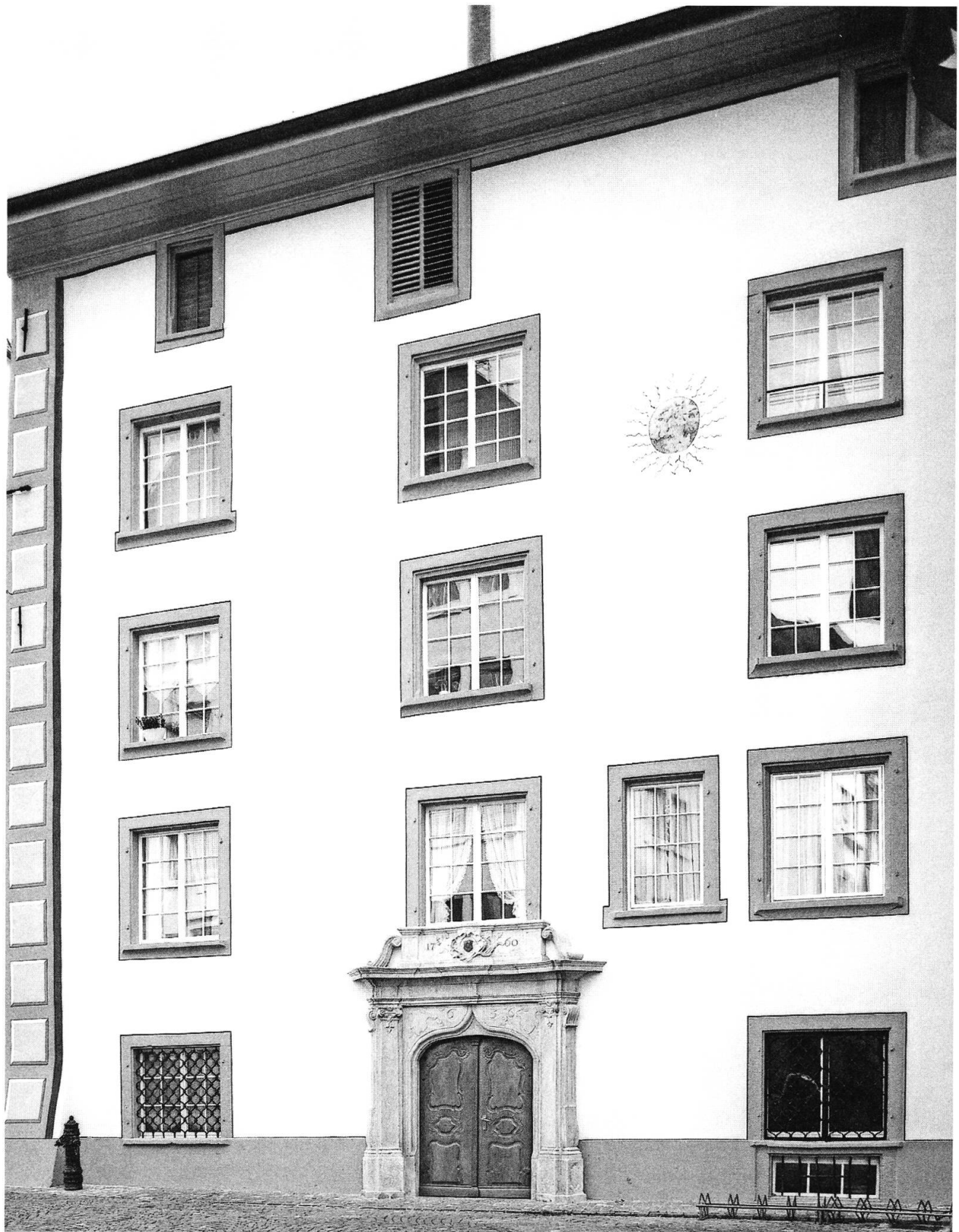
Westfassade Zustand 2008. (Bildarchiv Kantonale Denkmalpflege Aargau)
