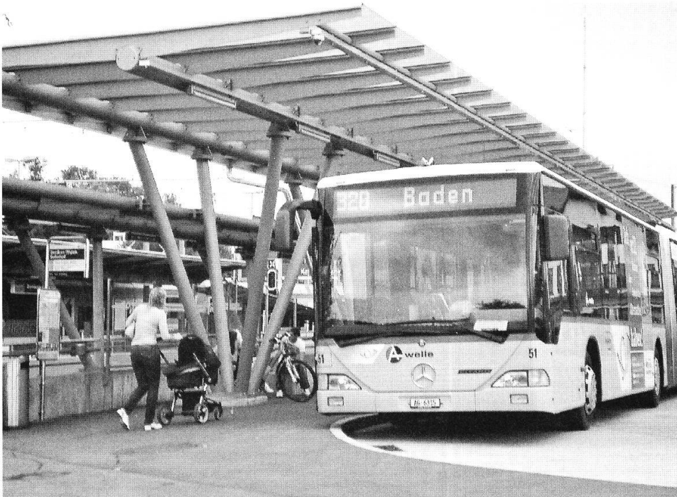
Postautohaltestelle beim Bahnhof Berikon- Widen mit dem neuen Perrondach.
