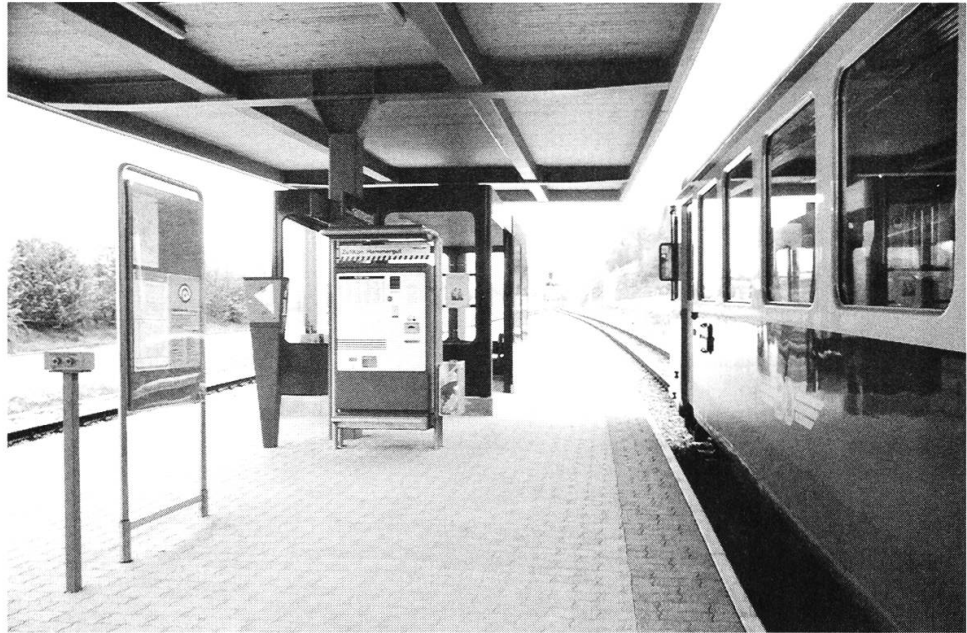
Perronausrüstung in Zufikon Hammergut mit Billettautomat, Infosäule, Informa- tionsstände und Anforderung für Be- darfshalt der Züge.
