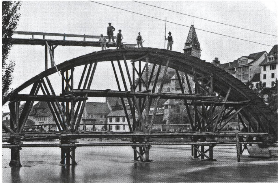
Brückenstadt im Eisenbahn- zeitalter: Bau der Eisen- bahnbrücke über die Reuss im Jahre 1912.
