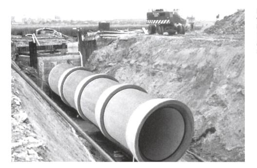
Im Kanalisationsbau wurden die grosskalibrigen SBR-Rohre der Firma Comolli eingesetzt, Durchmesser 150 Zentimeter.
