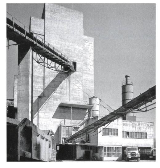
Über den unterirdischen Förderkanal wurde das Rohmaterial über eine Distanz von einem Kilometer zur Aufbereitung ins Kieswerk Wohlerstrasse transportiert.
