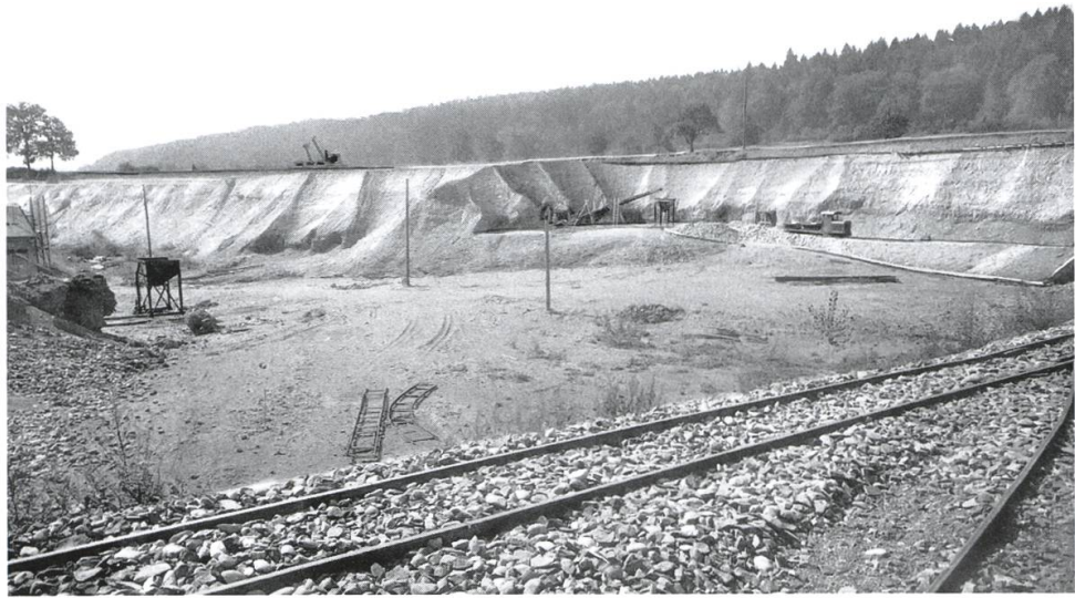
1948: Schienennetz, Draisine. Mit Diesellok und Rollwagen wurde das Material von der Abbaustelle zu den Aufgabesilos transportiert.
