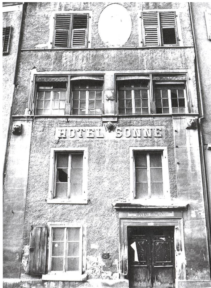
Das baufällige Hotel Sonne vor der Renovation.
