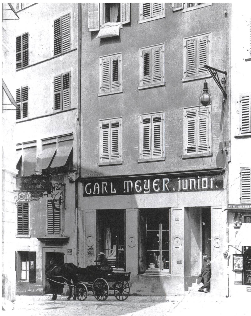
Lichtbogenlampe in der Marktgasse an der Liegenschaft Meyer. Die Bedienungseinrichtung und die Anschlussdrähte sind sichtbar. Bild: Sammlung Rolf Meyer.
