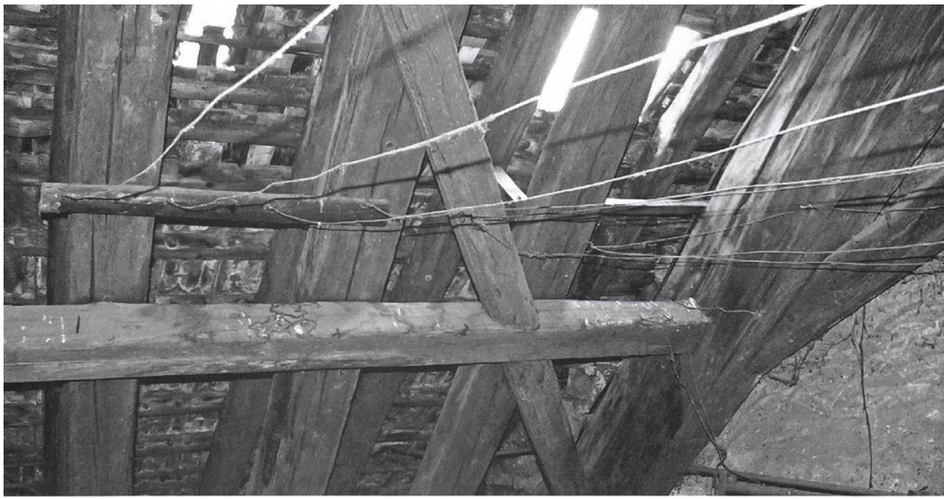
Blick in den alten Estrich mit Wäschehänge.
