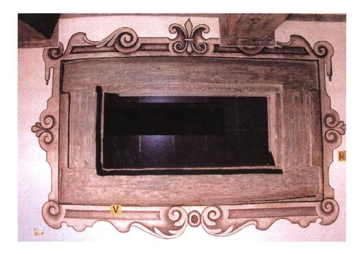
Die Malereien werden auch um Fenster und Türen vermutet. Es ist wichtig, dass in naher Zukunft der Dispersionsanstrich entfernt wird. Durch den kompakten Anstrich bleibt die Feuchtigkeit im Mörtel und beschädigt die Malereien. Es bildet sich eine Versalzung, bis der Mörtel abgestossen wird. Das bedeutet, dass dadurch wertvolle Bilder zerstört werden und der Nachwelt verloren gehen.
