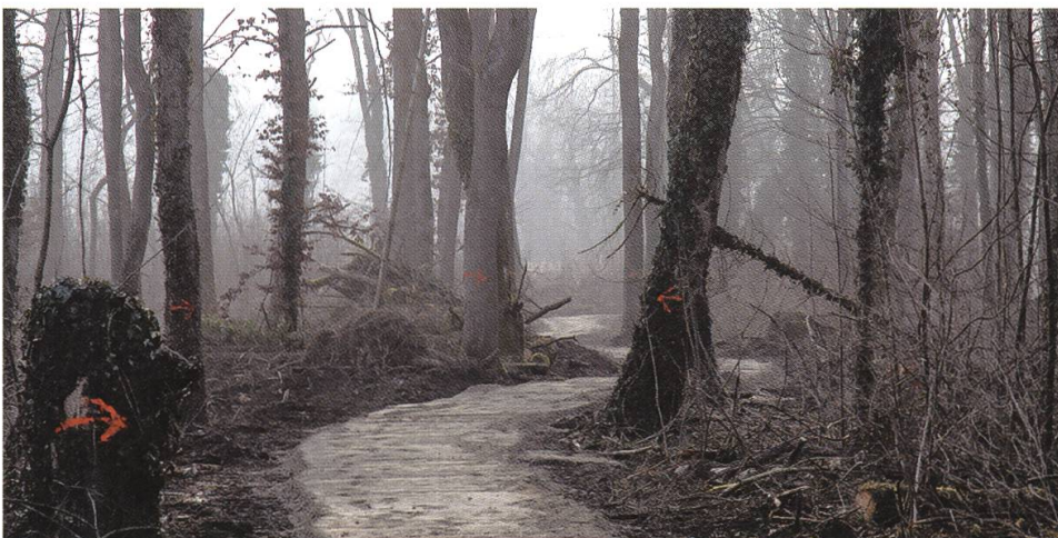
Gestaltung des neuen Wanderweges, die Pfeile führten den Bagger durch den Wald.
