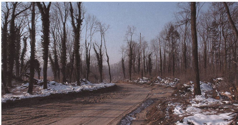
Unterer Seitenarm flussaufwärts nach dem Abschieben der sandigen Humusschicht.
