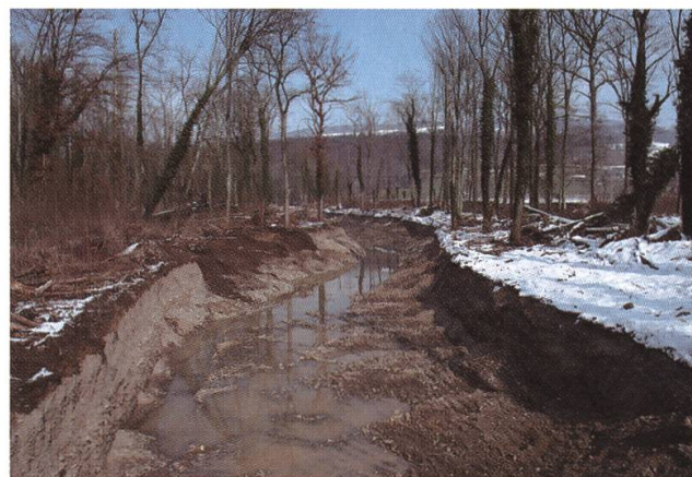
unten: Gleicher Abschnitt mit Durchfluss bei normalem Sommerwasserstand. Ausschnitt wie oberes Bild.
