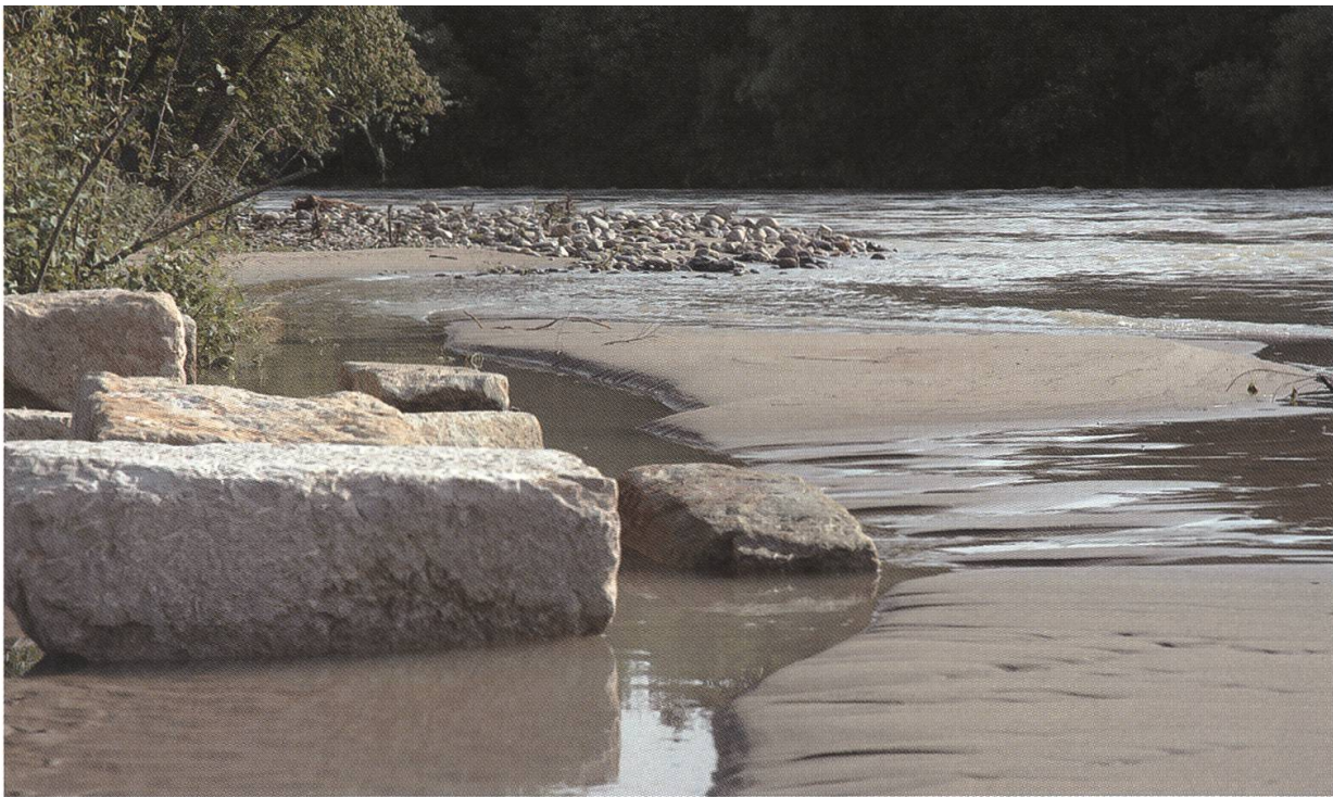
Picknickplatz mit Sitzsteinen aus der ehemaligen Uferverbauung kurz nach dem Hochwasser 2005.
