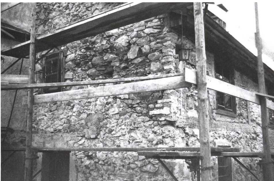
Die schräg-horizontale Baufuge unter dem Verputz über der Sakristei wurde ebenfalls bei den Renovationsarbeiten 1982 entdeckt. Um 1676 war die niedrige Einsiedlerklausen hier aufgestockt worden. Foto: Pater Siegfried Müller, Bremgarten.
