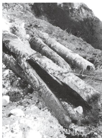
Alte Tünkelleitungen aus dem Vogelsang (Fund 2003).
