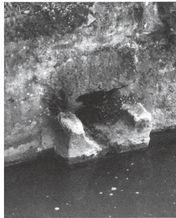
Ausfluss des Stadtbaches oberhalb der Holzbrücke.
