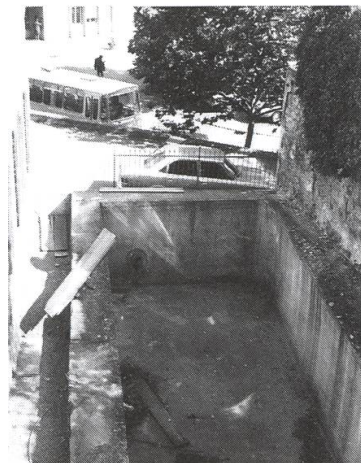
Altes Feuerwasserreservoir beim Oberen Zoll.
