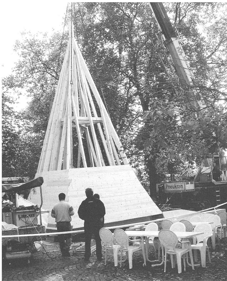
Mit dem Aufsetzen des 9,4 Meter hohen Turmhelms nähern sich am 17. Oktober die Sanierungs- und Umbauarbeiten des Katzenturms ihrem Abschluss.
