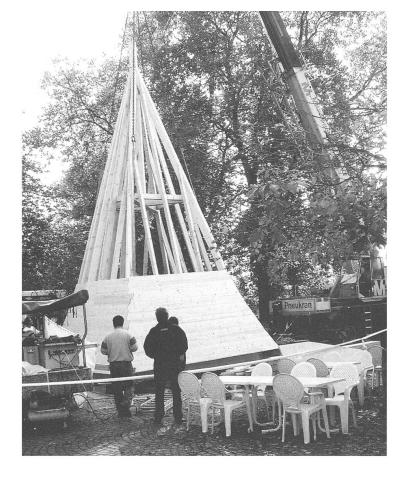
Mit dem Aufsetzen des 9,4 Meter hohen Turmhelms nähern sich am 17. Oktober die Sanierungs- und Umbauarbeiten des Katzenturms ihrem Abschluss.
