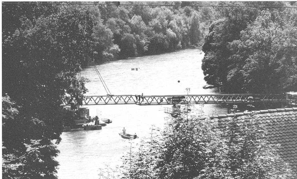
Bei sommerlichen Temperaturen werden die einzelnen Elemente des neuen Stegs eingebaut und miteinander verschraubt.
