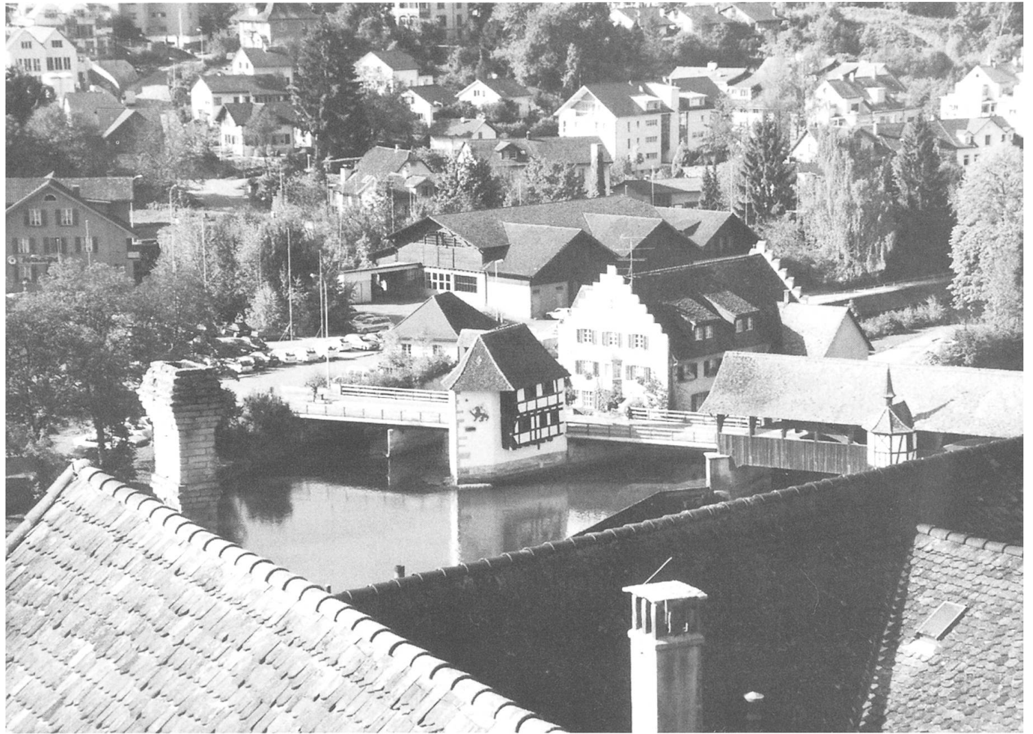
Der Blick vom Spittel- turm gegen Westen mit der Holzbrücke, dem Bollhaus und dem Wasserkraft-Museum zur Bruggmühle im Mittelpunkt.
