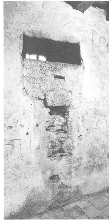
Abb. 5: Fenster an der Westwand des Turmgefängnisses.
