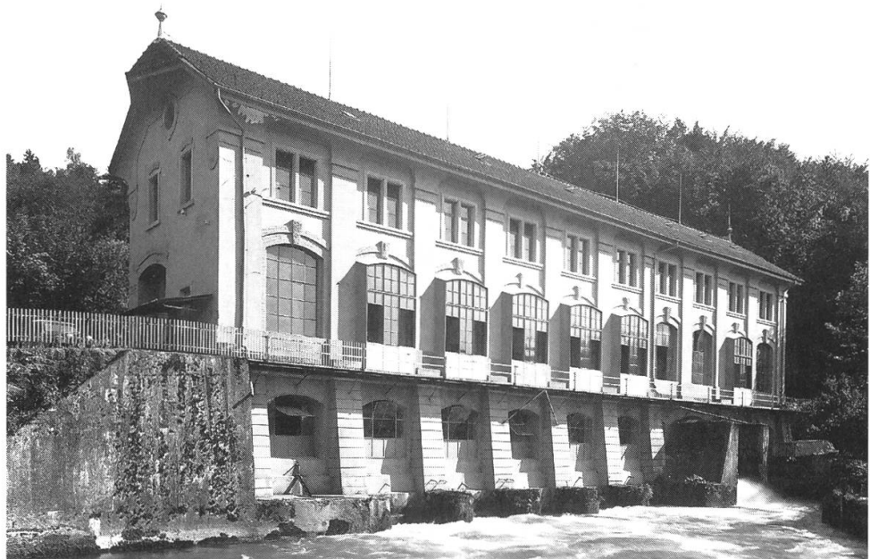
Maschinenhaus nach der Erweiterung für die 5. Turbine. (Foto 1946)
